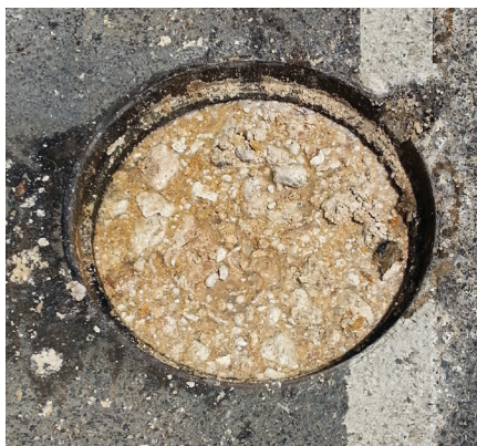
Una alcantarilla de la ciudad ahogada por la grasa que pasa a través de una trampa de grasa mal cuidada.
